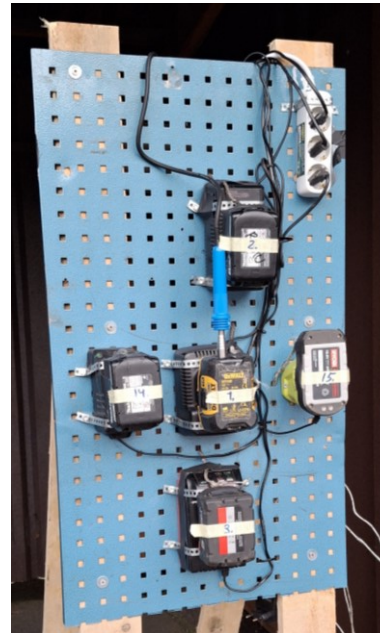
LION akkupalo työkaluseinä
